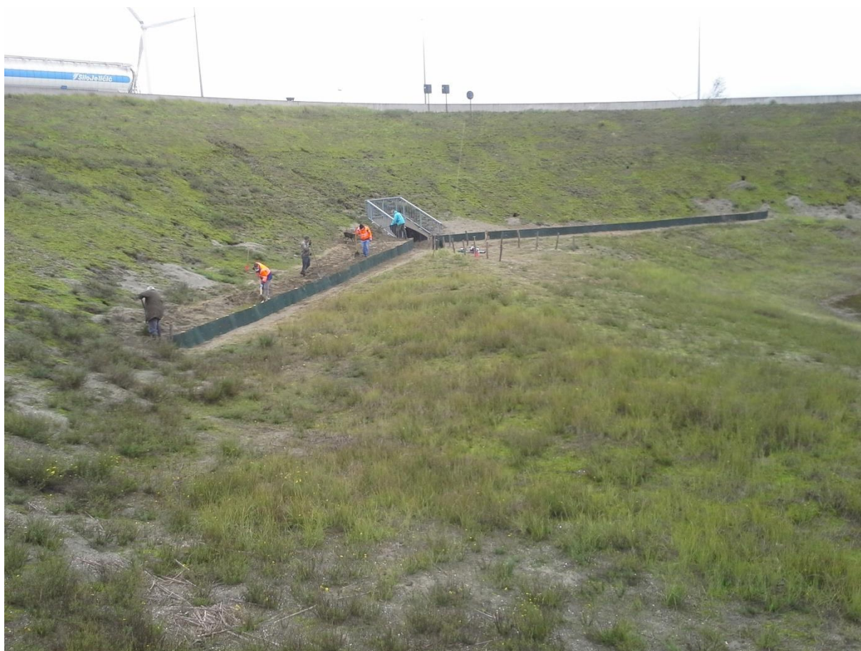
Figuur 107: De aanleg van geleidingswanden voor Rugstreepad aan de amfibieëntunnel in het rondpunt Haandorp (foto: Johan Baetens)
