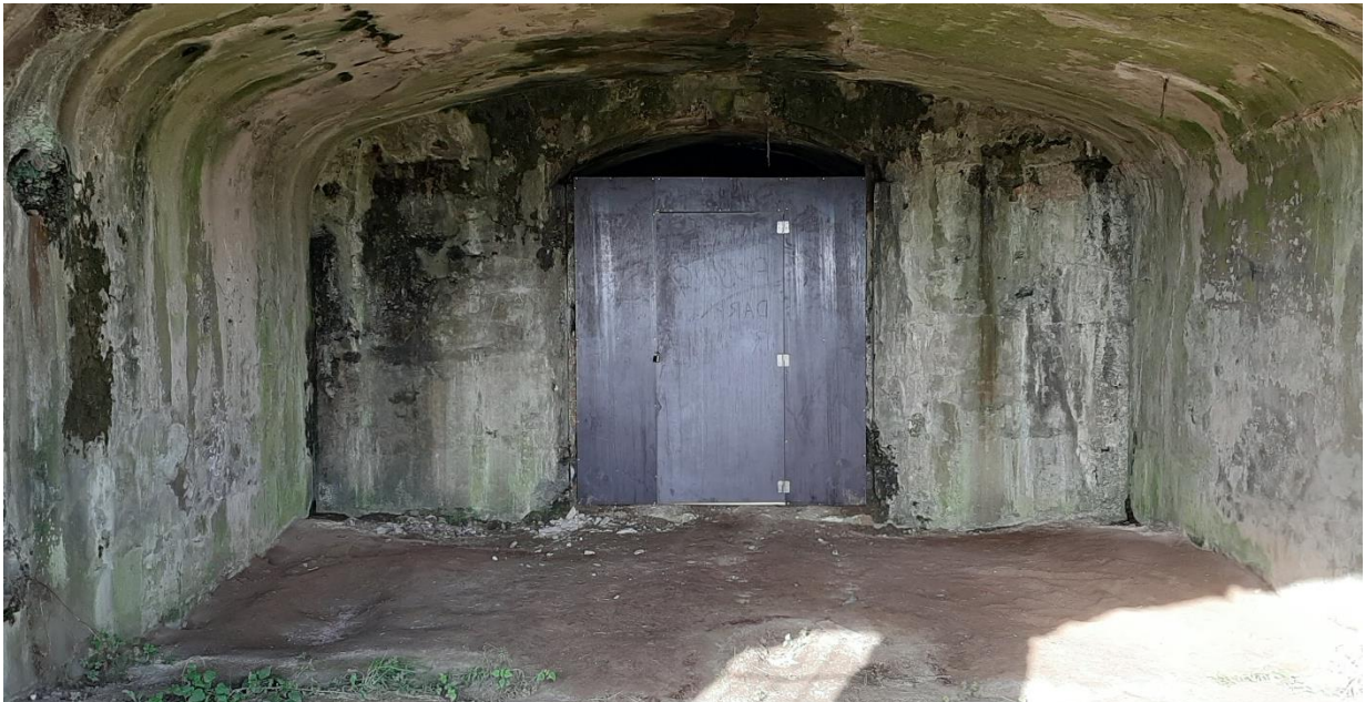
Figuur 96: In het najaar van 2020 geplaatste binnendeur in 1 van de caponnières langs de Verlegde schijns (foto: Ludo Benoy)
